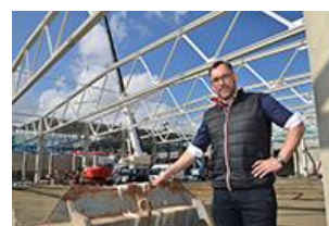
Capron-Geschäftsführer Daniel Rogalski auf der Baustelle der neuen Produktionshalle © Capron GmbH, F. Kramer
