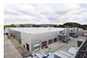
Die Baustelle für die neue Teilefertigungsstätte und das Ausbildungszentrum auf dem Gelände der Reisemobil-Fabrik Capron © Capron GmbH
